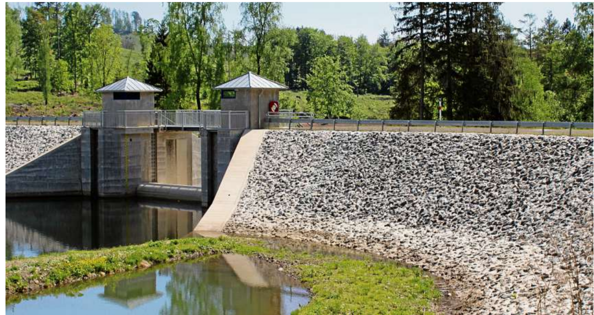
Das neugestaltete Becken der Sösetalsperre, das größere Wassermengen aus der Hauptsperre aufnimmt und diese ausgleicht.
