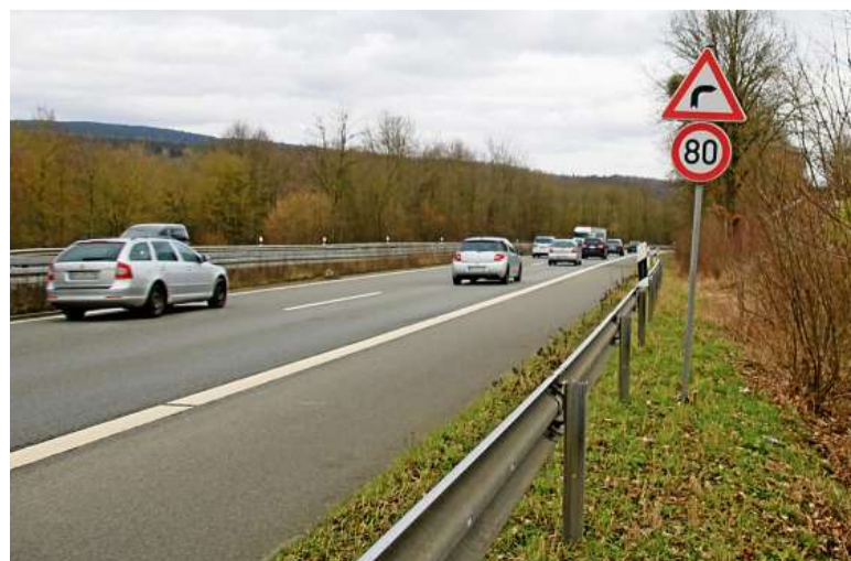
In der Leegekurve starten ab Montag erste Maßnahmen zur Einrichtung einer Baustelle.
